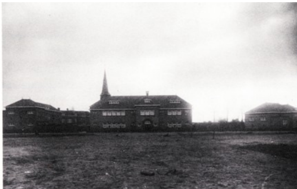
St. Catharinaschool, St. Bavo school en het gymlokaal, op dit laatste gebouw na letterlijk vergane glorie.
