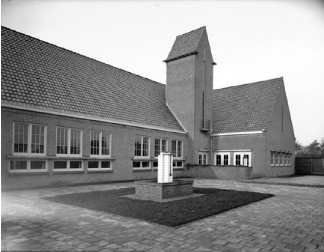
Berkenstraat 60, vlak na voltooiing van het gebouw
