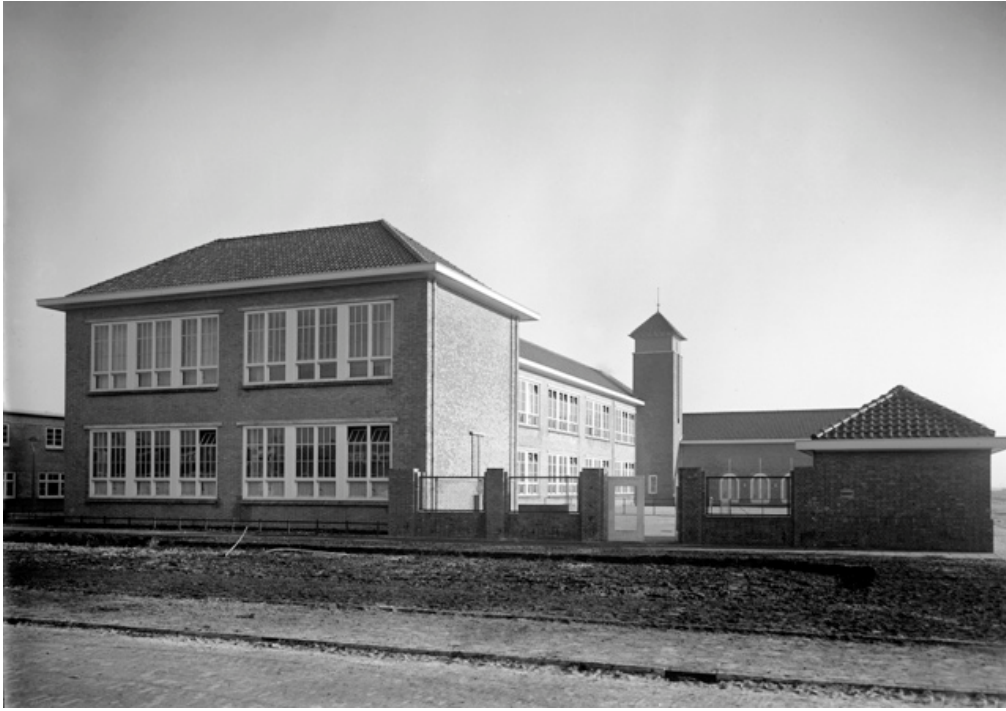
Het gebouw, vlak na de voltooiing in 1930.
